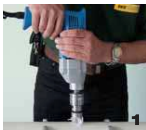
Специальной фрезой высверлить отверстие для седла
