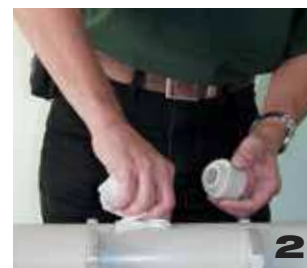
Зачистить. Если применяется трубка Stabi, то у высверленного отверстия скосить фаску. Очистить и обезжирить фасонную часть и высверленное отверстие.
